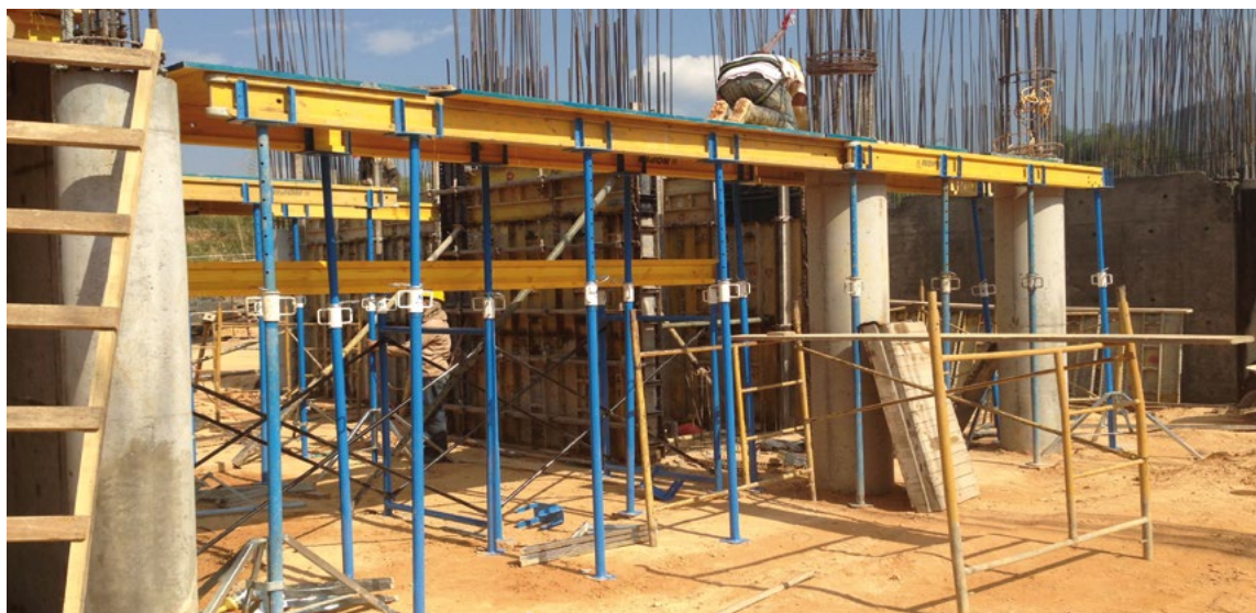
Escoramento e execução de vigas in-situ para lajes pré fabricadas
