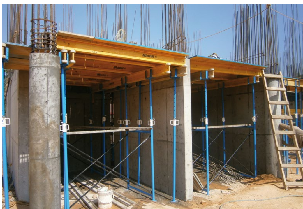
Escoramento de laje com muros
